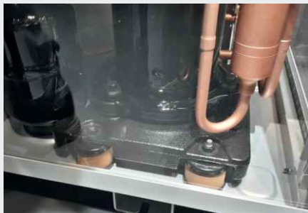
Isolation d'un assemblage de compresseurs sur un cadre intérieur
