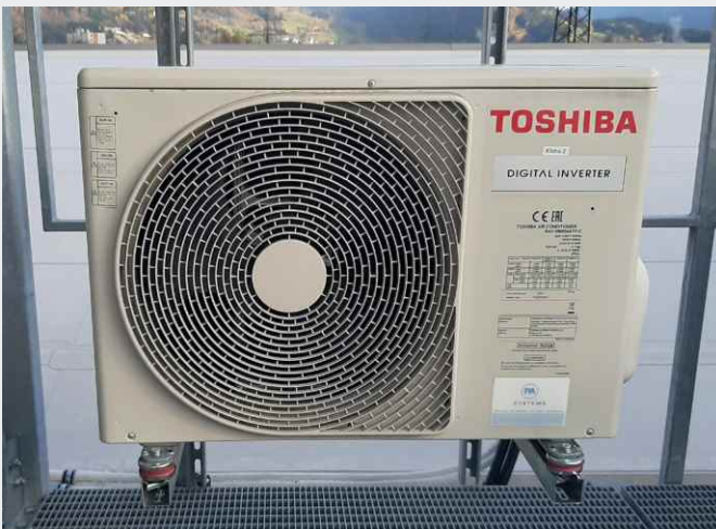
Unité extérieure d'un appareil de climatisation sur support mural
